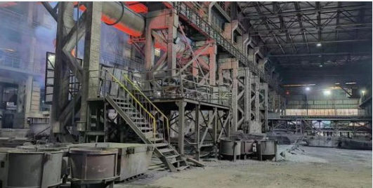
“矿热炉余热回收（煤气）发电项目” 生产线
